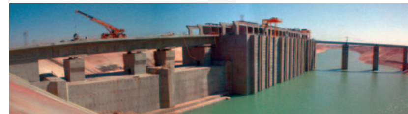
Station de Mubarak mise en eau, Egypte
