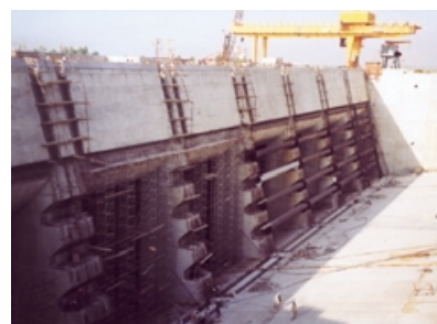
Pakistan, Aménagement hydroélectrique de Chashma
