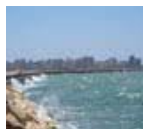
Port de Tripoli, Liban 2005 - 2008 Extension de la digue principale de 1500 m et nouveau quai conteneurs de 600 m DET (en association)
