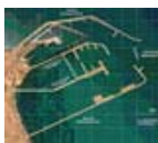
Port de Ras Laffan, Qatar 2006 - 2008 3 digues de 2, 10, 11 km et protection intérieure des terre-pleins et causeways PRO
