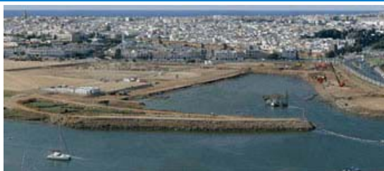
Aménagement du Bouregreg à Rabat, Maroc 2006 - 2008 Marina, quais fluviaux, dragages, plages, digues en mer, port de pêche AMO (en association)
