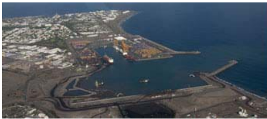
La Réunion Port Est Extension, France 2004 - 2007 Extension accès et bassin portuaire, quai de 600 m AVP / PRO / DCE / AMO
