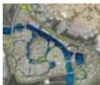
Aménagement de Amwaj à Rabat, Maroc 2006 - 2009 Nouvelle urbanisation lacustre sur 500 ha. Marinas, canaux, quais, pontons AVP / DCE / DET (en association)
