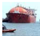
South Pars Terminal LNG, Iran 2006 - 2007 Jetée en mer, protections, station de pompage, prise d'eau et rejet FEED
