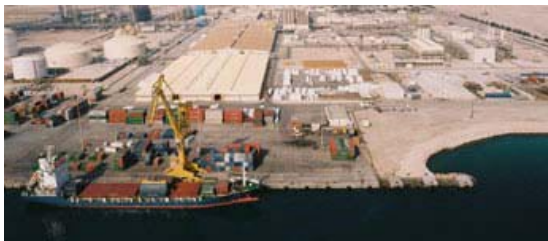
Qatofin Terminal pétrochimique de Messaïed, Qatar 2004 - 2008 Nouveau quai et terre-plein d'exportation, prise d'eau et rejet, station de pompage Optimisation des flux / FEED / DET
