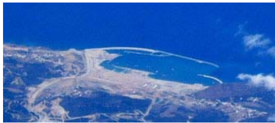
Tanger Nouveau Port Roulier, Maroc 2006 - 2007 Nouveau port roulier contigu au port de Tanger Med (Cf. photo, étudié par Sogreah en 2003) AVP / PRO / DCE
