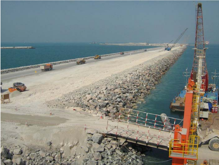
Vue partielle du brise-lames Sud
