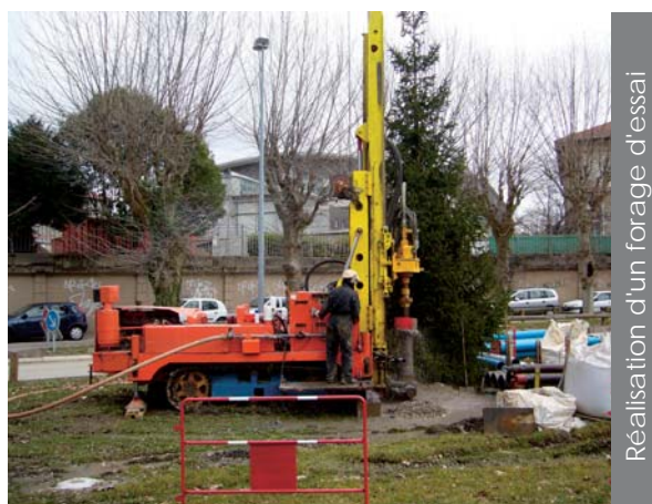
Instrumentation d'un piézomètre pour le suivi en continu du niveau d'eau
