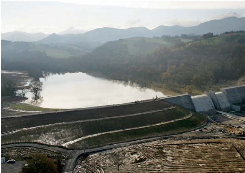
Barrage lors des essais de remplissage
