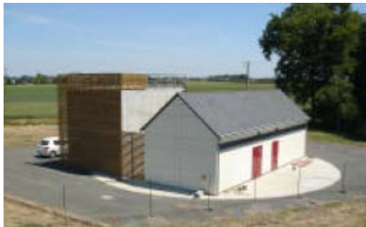
Station de pompage en Loire Débit : 7 200 m 3 /h - Hauteur de refoulement : 7,5 m
