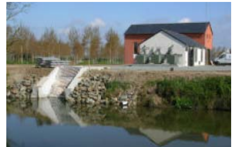
Station de pompage dans l'Authion Débit : 3 600 m 3 /h Hauteur de refoulement : 165 m
