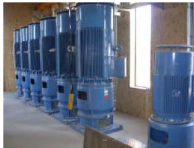
Station de pompage dans l'Authion Débit : 3 600 m 3 /h Hauteur de refoulement : 165 m
