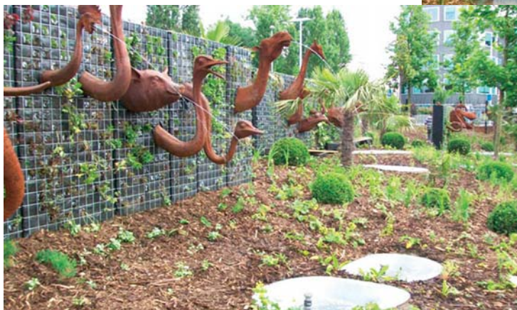
Murs végétalisés - Têtes cracheuses d'eau
